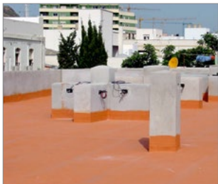
Hiszpania: budynek mieszkalny w miejscowości Vera
