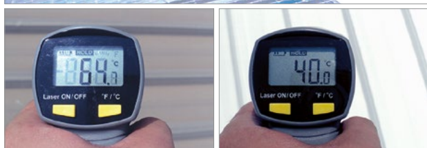
Capannone industriale in Malesia. Estradosso tetto capannone (prima-dopo): il rivestimento del tetto riduce la temperatura superficiale di 24,7°C.
