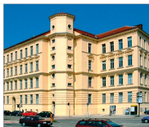
République tchèque: Brno, bâtiment administratif
