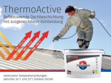
ThermoActive ist die klimatisierende Dachbeschichtung. Sie sorgt für kühlere Räume unter heißer Sonne. ThermoActive verlängert die Lebensdauer der Dachkonstruktion und senkt die Temperaturen im Gebäudeinneren. Das spart Ressourcen für die Wartung des Daches und reduziert die Energieverbräuche der Klimaanlagen.
