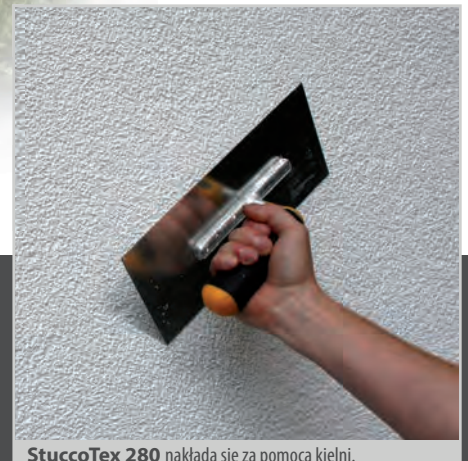
StuccoTex 280 nakłada się za pomocą kielni.
