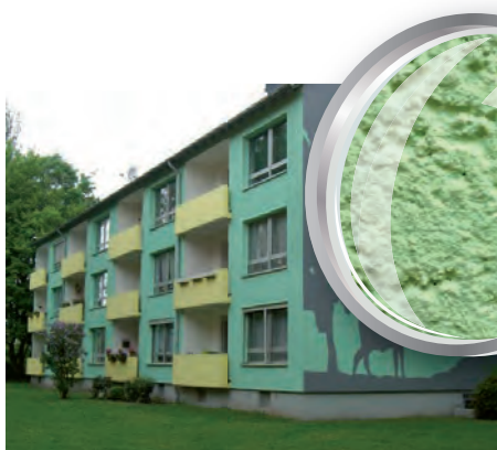
pomalowane ClimateCoating® ThermoProtect
