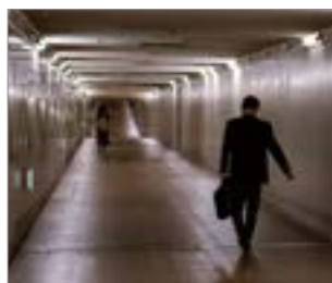
Oświetlanie przejść podziemnych
