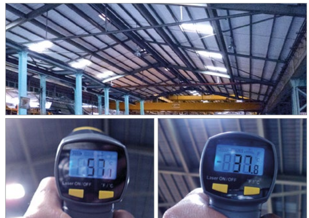
Hallendach innen (vorher–nachher): Die Temperatur wurde um 19,3°C gesenkt. Nutzen: Verbesserte Arbeitsbedingungen, Energieeinsparung, Kostensenkung der Dachwartung.
