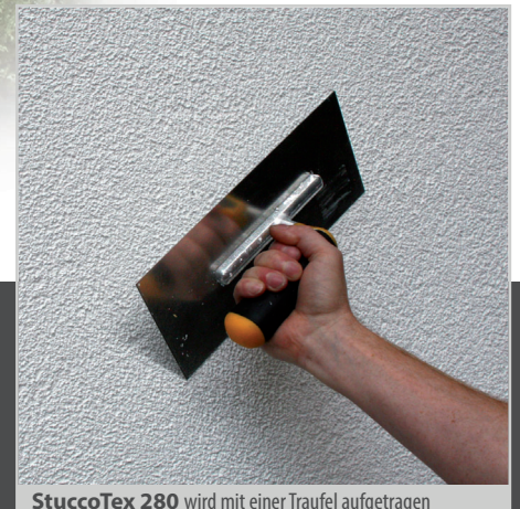
StuccoTex 280 wird mit einer Traufel aufgetragen
