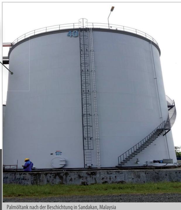
Palmenöltank nach der Beschichtung in Sandakan, Malaysia
