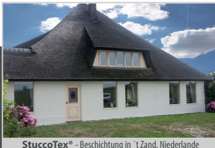
StuccoTex® - Beschichtung in 't Zand, Niederlande
