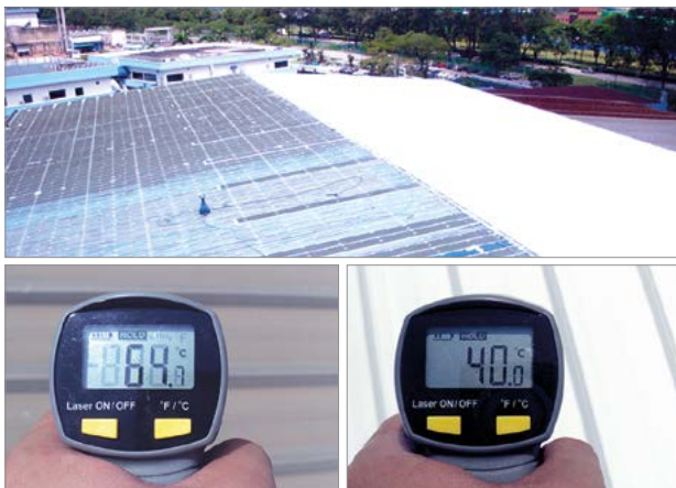
Industriehalle in Malaysia. Hallendach außen (vorher–nachher): Die Dachbeschichtung erbrachte eine Temperatursenkung von 24,7°C.
